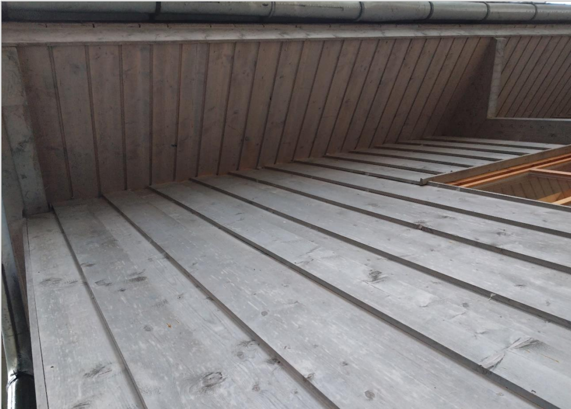
Abb. 10: Keine für Fledermäuse oder Gebäudebrüter nutzbaren Strukturen an Süd-, Ost- und Westseite der Turnhalle
